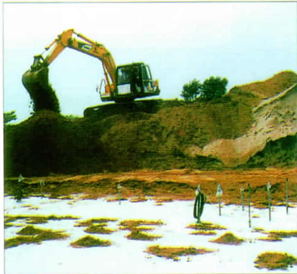
Thiết bị quan trắc đập gia cường bằng vải Polyfelt cao 6m trên nền đất yếu ở Bangkok.
