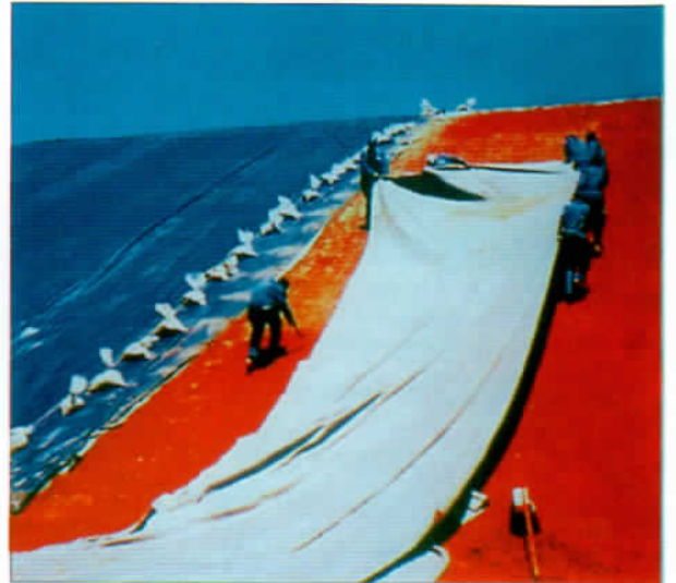
Dùng Polyfelt làm lớp lót dưới màng chống thấm của hồ chứa nước.
