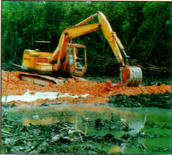
Polyfelt dùng để ổn định đất đắp trên nền đất yếu.
