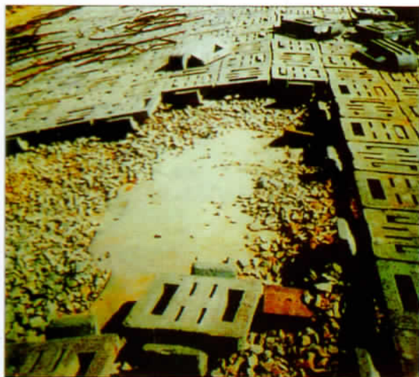
Dùng Polyfelt dưới tấm lát bê tông.
