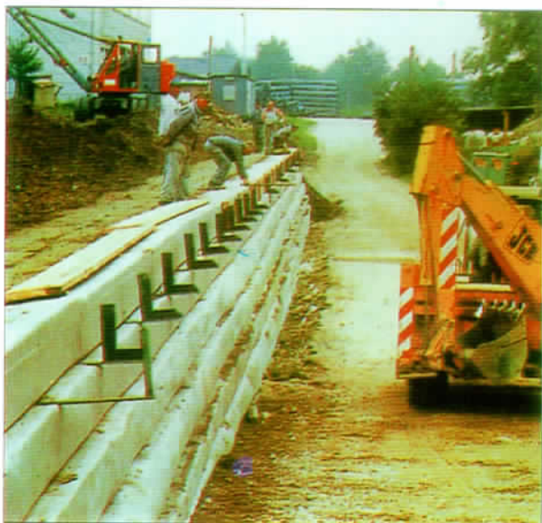
Mặt đứng của tường được thi công dễ dàng với cốt pha tạm.
