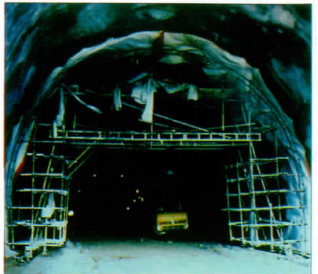
Polyfelt làm lớp bảo vệ chọc thủng và thoát nước sau màng chống thấm của áo đường hầm.
