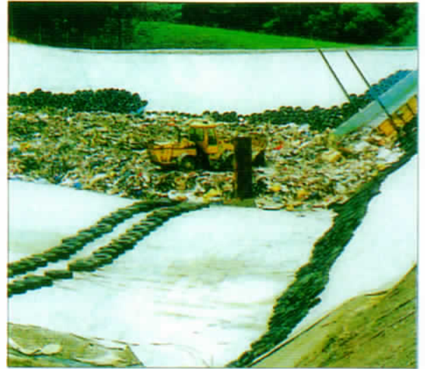
Sử dụng Polyfelt trong bãi chứa chất thải rắn, bảo vệ ứng suất xuyên thủng màng chống thấm.
