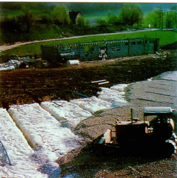
Polyfelt dùng cho sân vận động, sân golf cho phép thoát nước nhanh của các trận mưa lớn.
