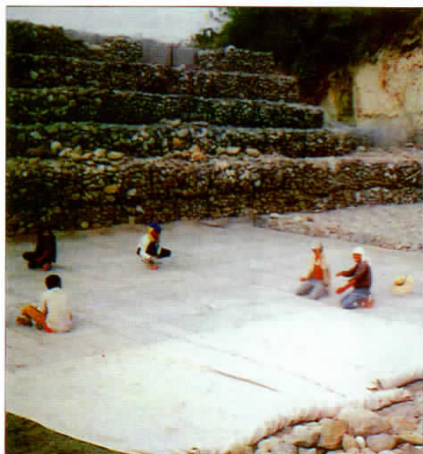
Lớp bọc Polyfelt trong thi công đập Gabion.
