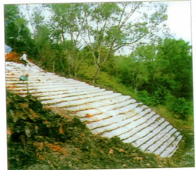
Sửa chữa mái dốc bị trượt ở Brunei, dùng đất sét để đắp với vải Polyfelt gia cường.
