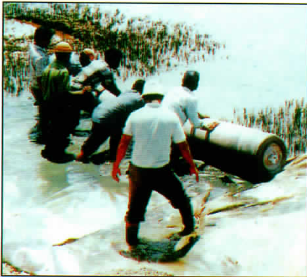
Polyfelt có thể trải trực tiếp trên nền đất yếu không cần bóc hữu cơ.
