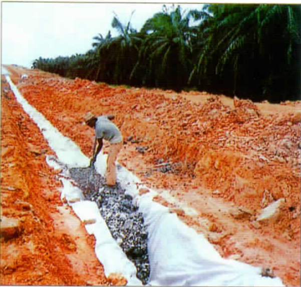
Thi công rãnh tiêu nước.
