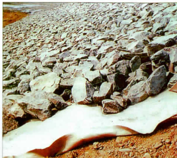
Gia cố mái dùng vải Polyfelt.
