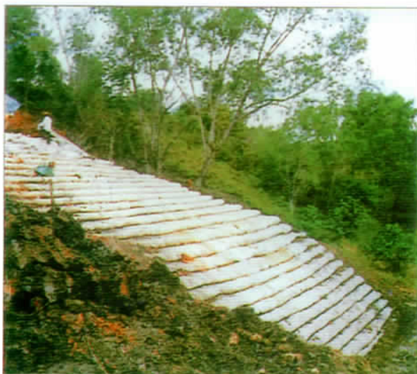
Sửa chữa mái dốc bị trượt ở Brunei, dùng đất sét để đắp với vải Polyfelt gia cường.
